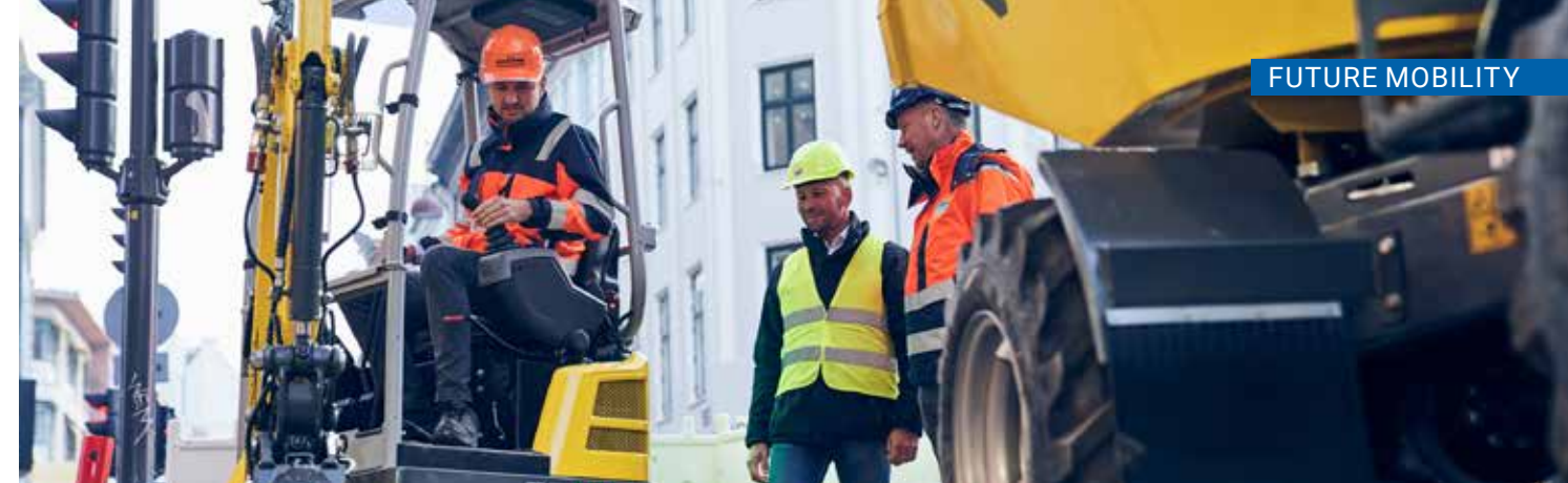
100 % emissionsfreies Arbeiten: Der vollelektrische Minibagger von Wacker Neuson hat auch auf Baustellen von Swietelsky schon Einsatz gezeigt. Bild: Wacker Neuson
